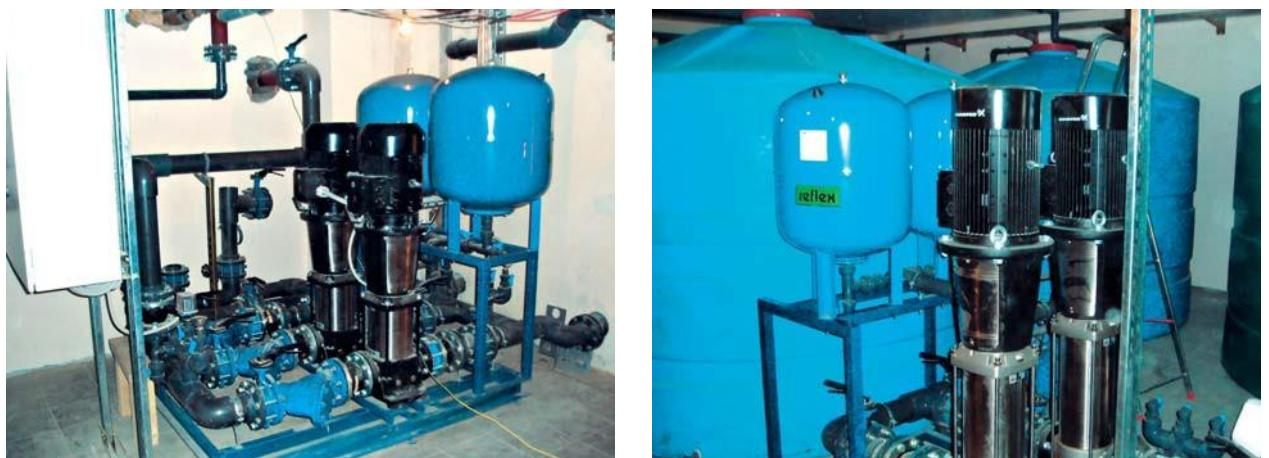
На фото представлены автоматизированные насосные станции с подачей воды 0-60 м<sup>3</sup>/ч в производственном здании на базе насосов GRUNDFOS CR
