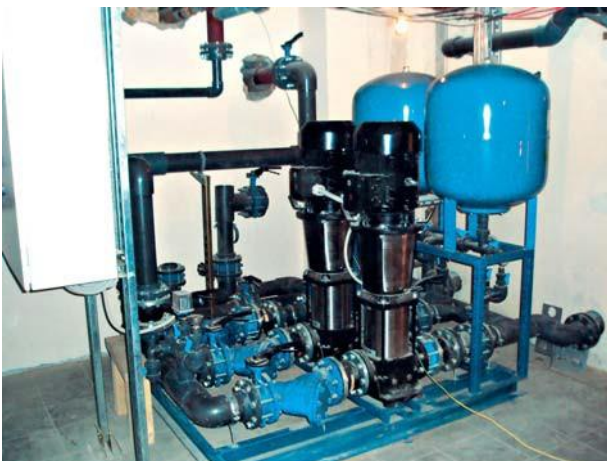
На фото представлены автоматизированные насосные станции с подачей воды 0-60 м 3 /ч в производственном здании на базе насосов GRUNDFOS CR
