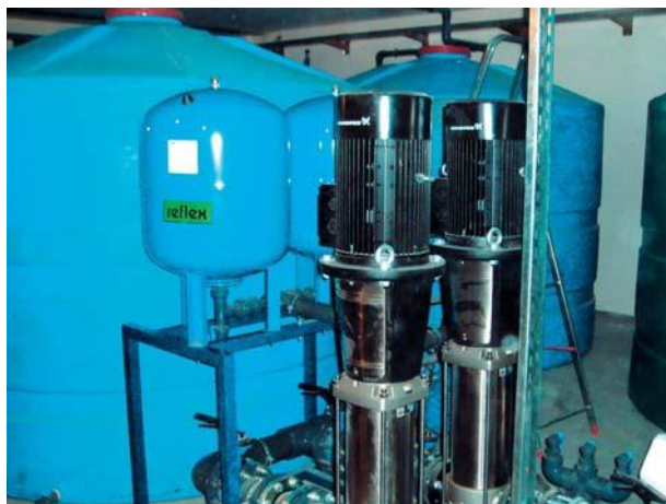
На фото представлены автоматизированные насосные станции с подачей воды 0-60 м 3 /ч в производственном здании на базе насосов GRUNDFOS CR
