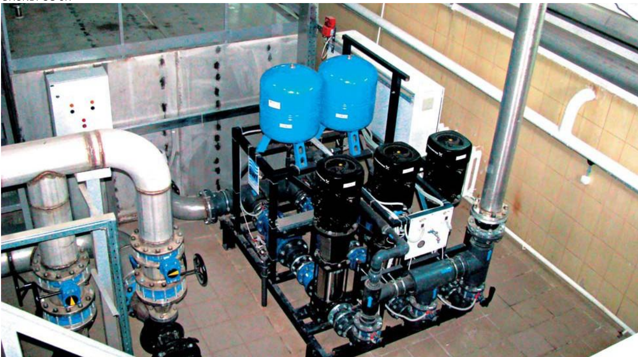
На фото представлены автоматизированные насосные станции с подачей воды 0-60 м 3 /ч в производственном здании на базе насосов GRUNDFOS CR
